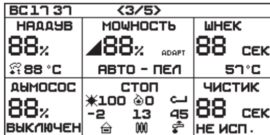
Экран №3 «Работа котла»
